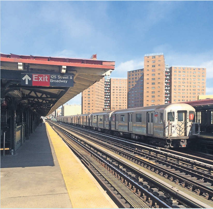
Der Bahnhof an der 125th Street / Broadway. (Bild: Schmied/Gloor)
